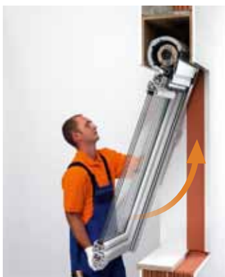
Fenster mit TERMO einsetzen.
